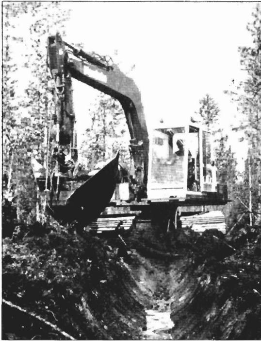
Kuva 1. Sarkaojan kaivua ohutturpeisella suolla Poclain 75CKB-kaivukoneella.
