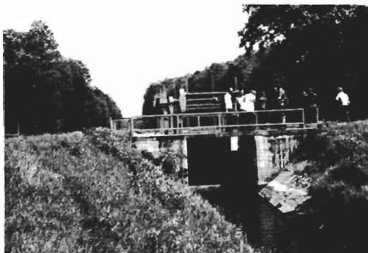
Kuva 5. Kanavan sulkupato, jolla vesi voidaan nostaa kuivina vuosina ojitetuille metsämaille ja pelloille vieviin ojiin.
