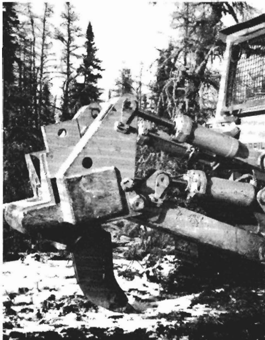
Kuva 6. Kaivutyön helpottamiseksi jouduttiin 40 cm syvä routakerros rikkomaan kantokoukun tapaisella laitteella.
